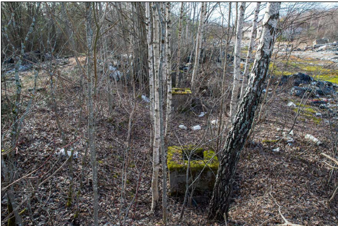
Foto 18 (562). Kiltsi lennuvälja kütuseladu. Hoone [4] ja sissesõidutee [12] vahel võsas on mingid betoonalused. Taga paremal paistab hoone [2]. Foto Mart Mõniste 11.03.2014.
