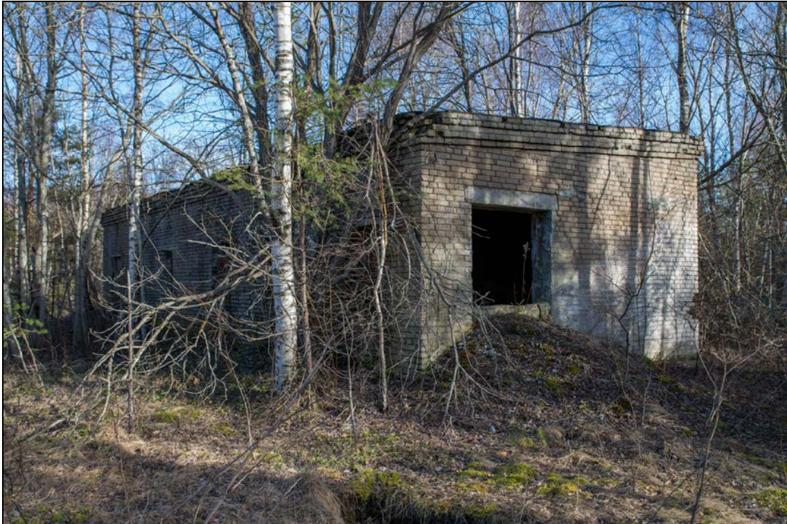
Foto 34 (698). Kiltsi lennuvälja kütuseladu. Hoone [11] lao esimeses servas, sissesõidutee ääres vōsas. Kōik aknad on kinni mūūritud ja kasutatud tsemendihoidlana. Foto Mart Mōniste 11.03.2014.
