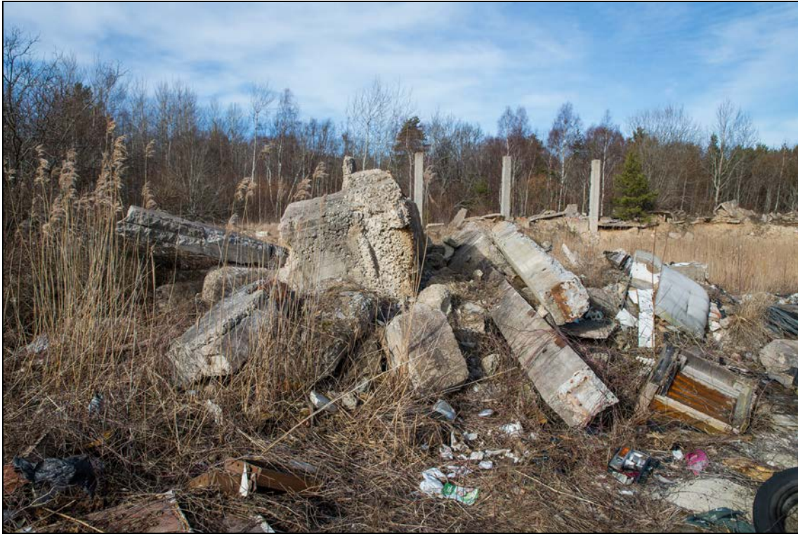
Foto 17 (571). Kiltsi lennuvälja kütuseladu. Lammutatud hoone [4]. Foto Mart Mõniste 11.03.2014.
