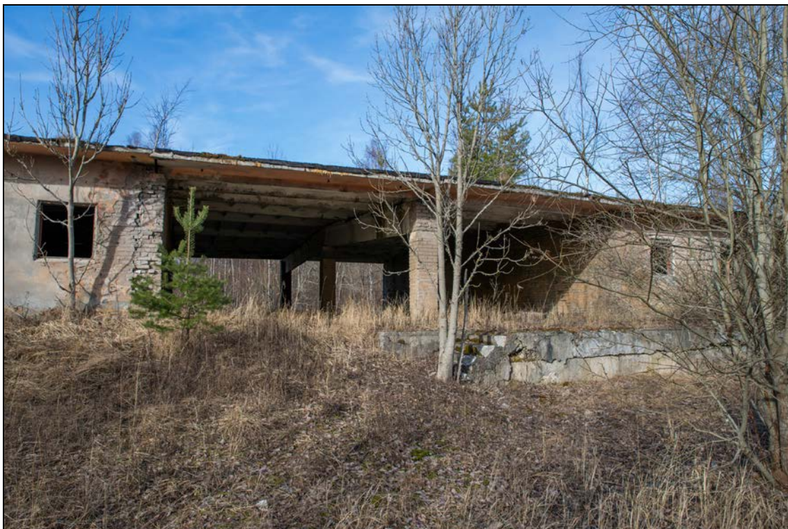
Foto 11 (635). Kiltsi lennuvälja kütuseladu. Laohoone [3], vaade [9] suunast. Foto Mart Mõniste 11.03.2014.
