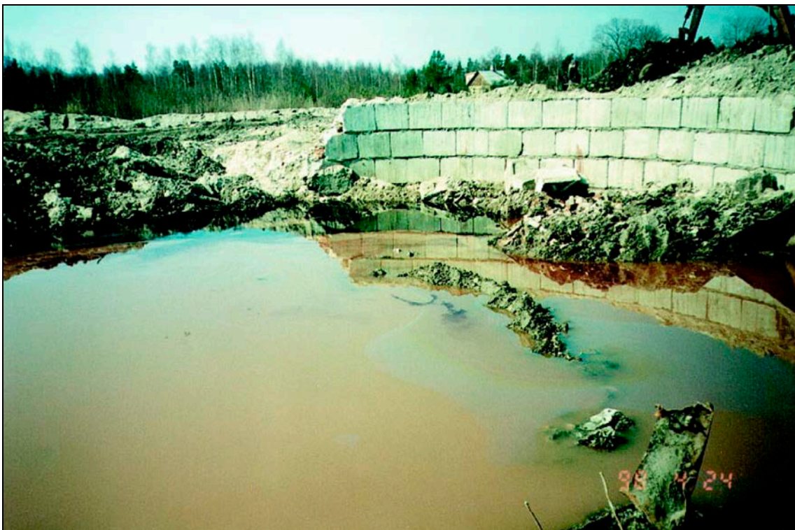
Foto 41. Rohkesti naftajäätmeid sisaldava 200 m 3 suuruse kütusemahuti likvideerimine Paralepa lennuväljal. Tõnis Meriste foto raamatust „Endise Nõukogude Liidu sõjaväe jääkreostus ja selle likvideerimine”
