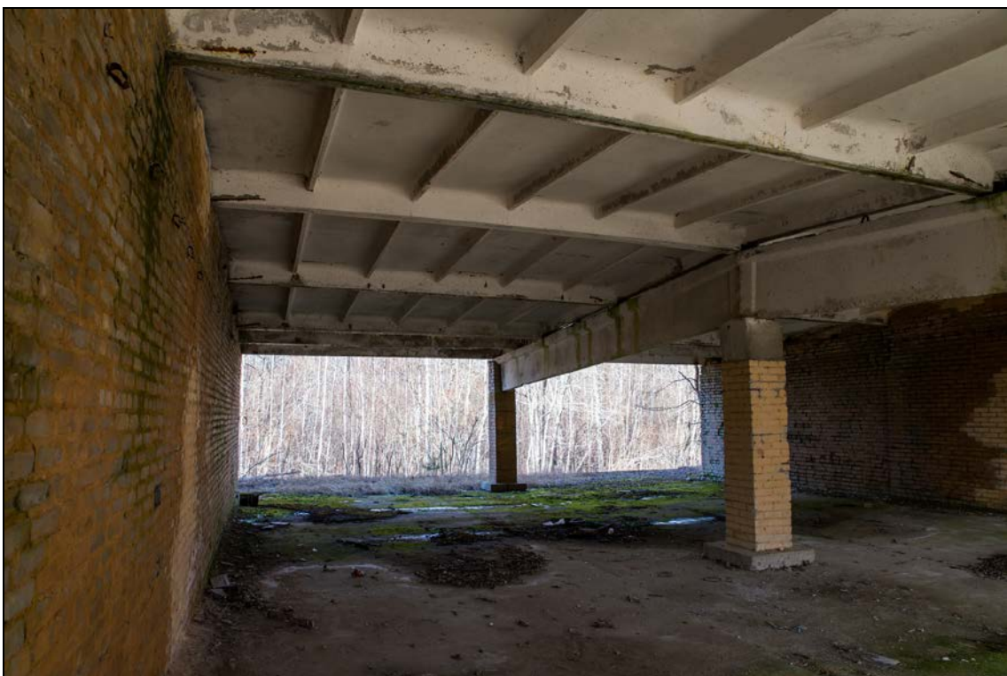
Foto 14 (648). Kiltsi lennuvälja kütuseladu. Laohoone [3]. Foto Mart Mõniste 11.03.2014.
