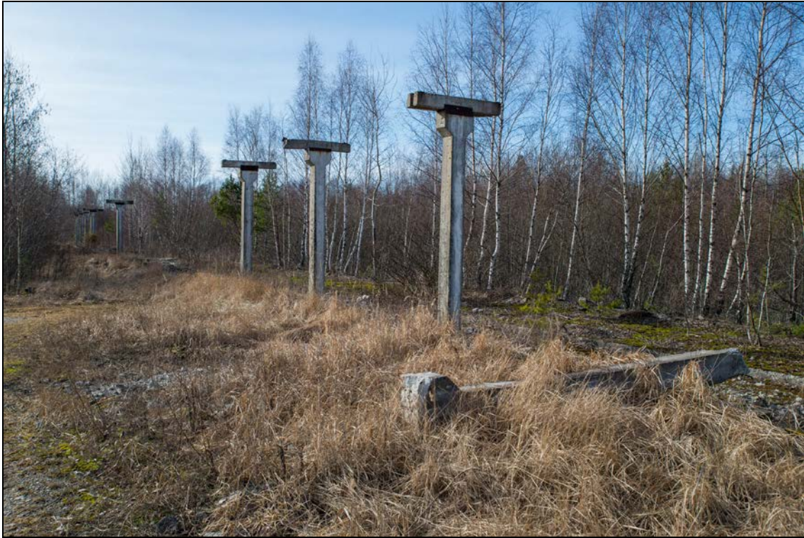
Foto 19 (623). Kiltsi lennuvälja kütuseladu. [5], torustiku tugipostid? Foto Mart Mõniste 11.03.2014.
