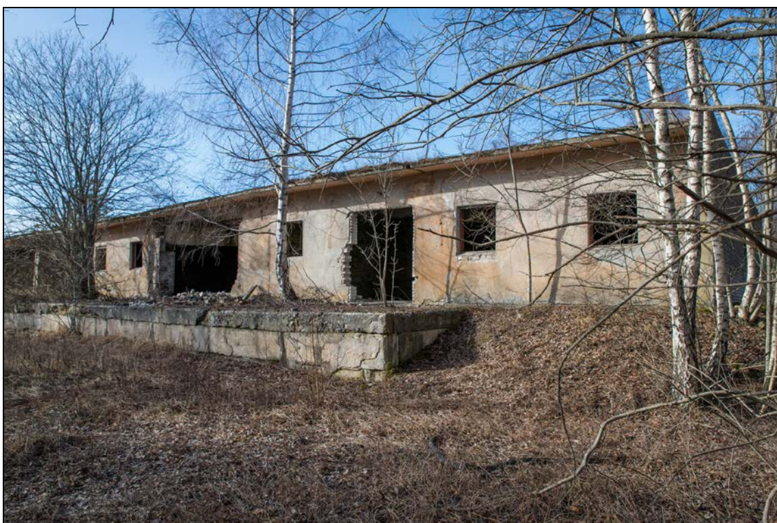
Foto 12 (637). Kiltsi lennuvälja kütuseladu. Laohoone [3]. Foto Mart Mõniste 11.03.2014.
