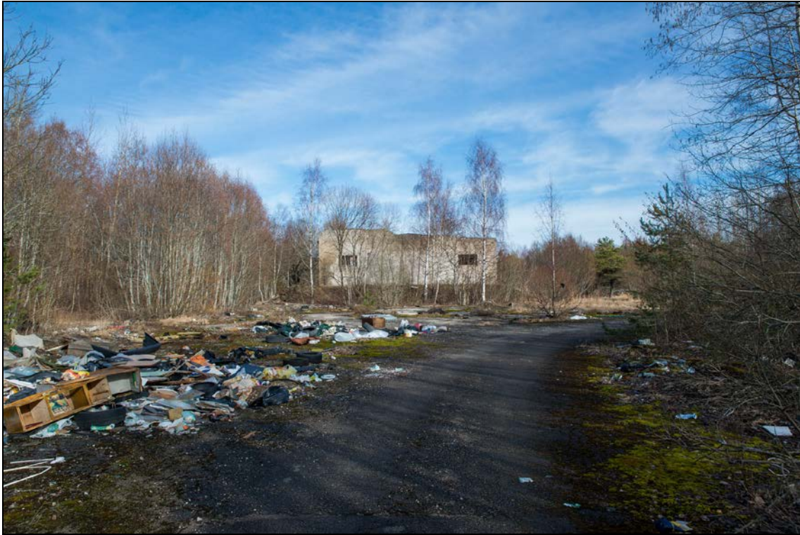
Foto 7 (604). Kilti lennuvälja kütuseladu. Laohoon [2], vaade [3] suunast. Kahe suurema laohoon vahel on betoonirusu ja lammutusjääke. Foto Mart Mõniste 11.03.2014.
