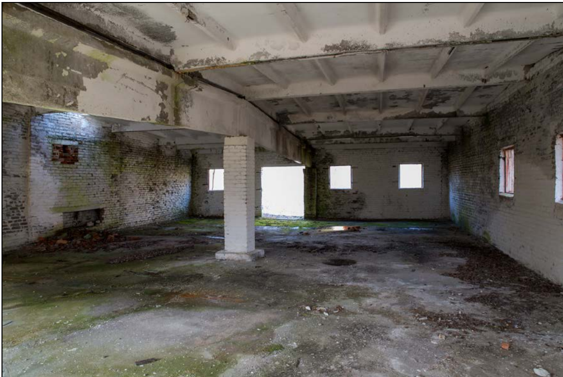
Foto 12 (642). Kiltsi lennuvälja kütuseladu. Laohoone [3], tundub olevat vanem ehitus kui ladu (2), katus jookseb rohkem läbi. Foto Mart Mõniste 11.03.2014.
