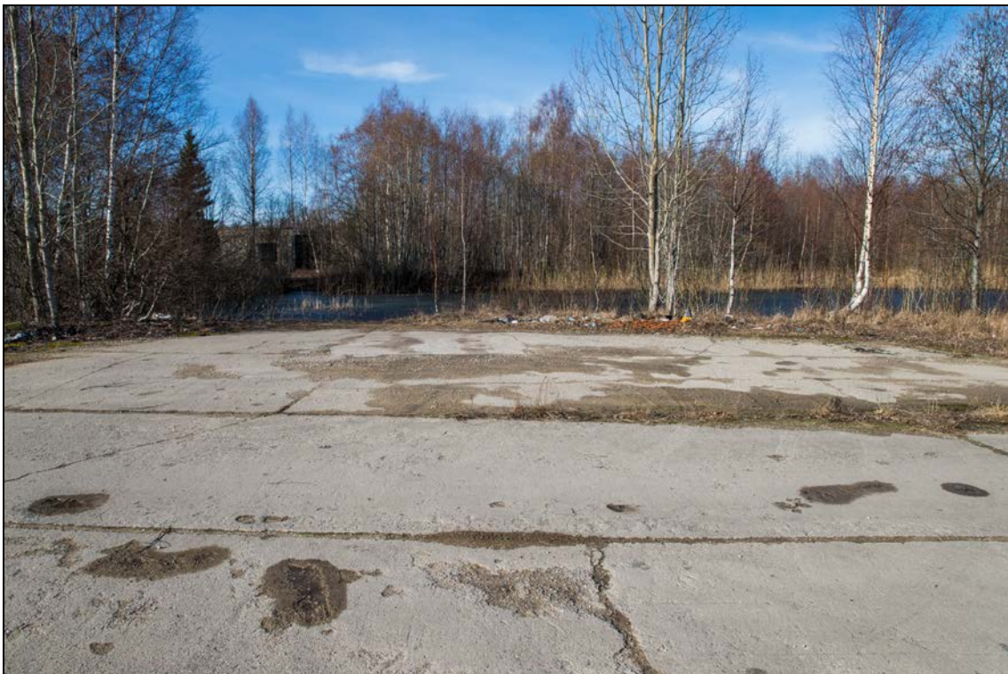
Foto 26 (682). Kiltsi lennuvälja kütuseladu. Ilmselt tuletõrje veehoidla [10], tiigi mõõtmed 25x50 m, selle kõrval betooneeritud tee laiendus, taga vasakul paistab hoone [9]. Foto Mart Mõniste 11.03.2014.
