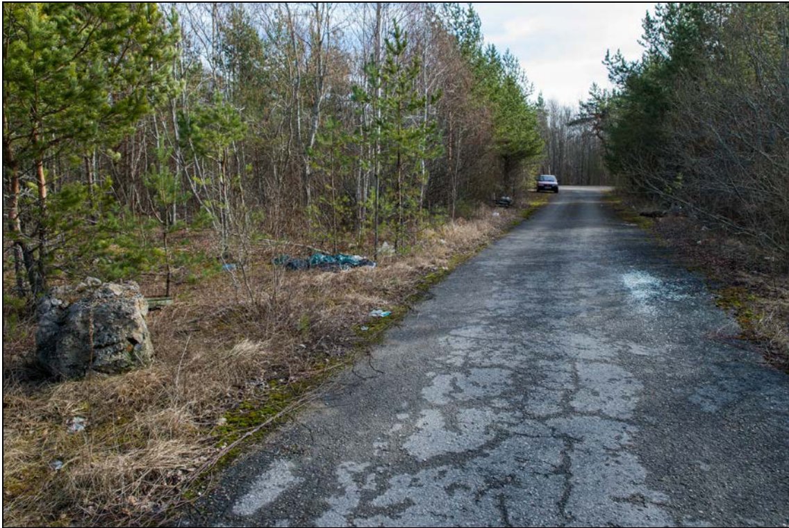
Foto 1 (554). Kilti lennuvälja kütuseladu. Sissesõidutee, värava asukoht, vaade [2] suunast. Foto Mart Mõniste 11.03.2014.
